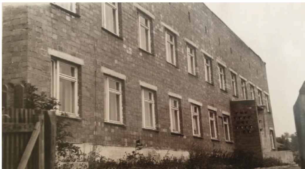
Новое здание Семеновской СЭС (ул. 9-е Января)
